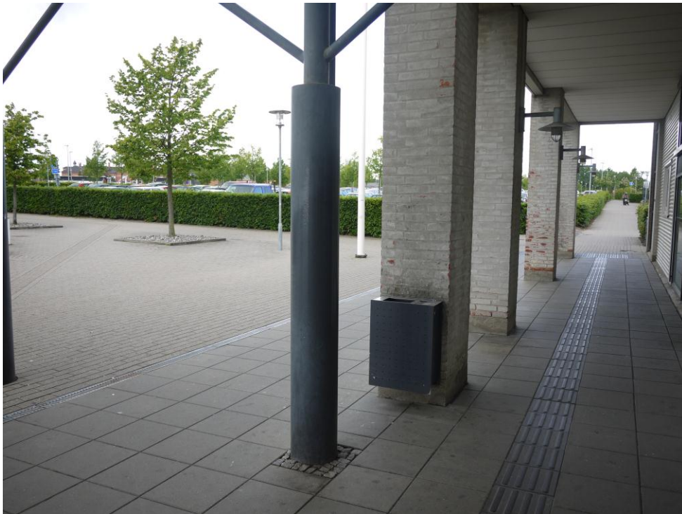
Kig mod højre fra udgang ved stationsbygning
