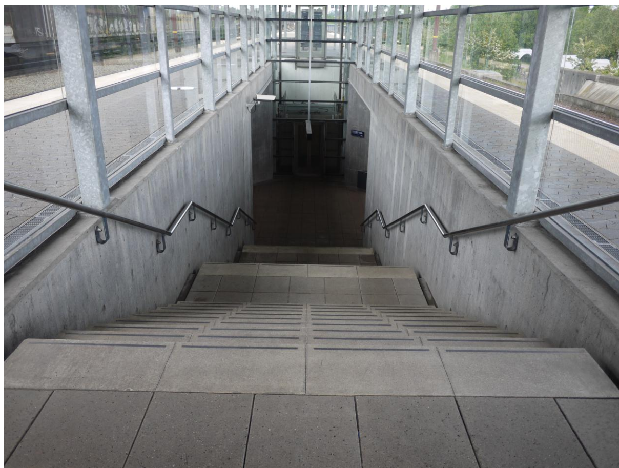
Fra perronen og ned mod tunnelen
