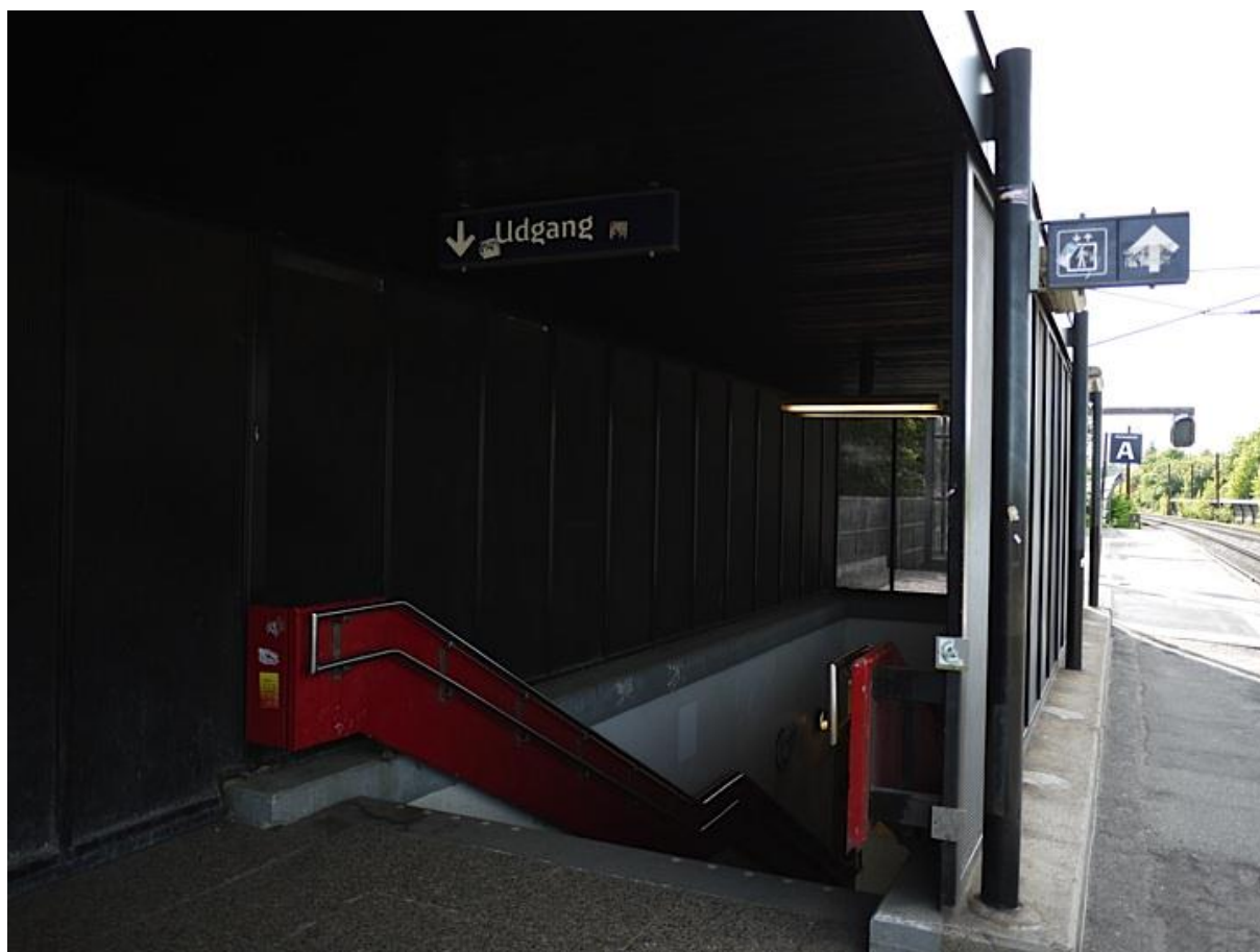
Fra perronen og ned mod tunnelen
